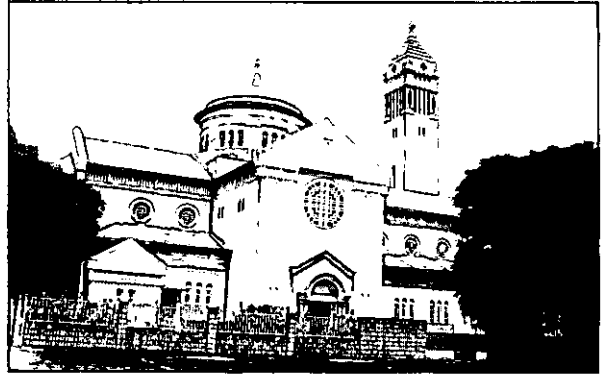
Un exemple de bâtiment public : la cathédrale de Conakry.
